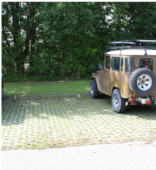
Rådhuset i Højby har permeable belægning til parkeringspladser, som gør det nemmere for vandet til at sive ned og samtidig gør det gaden mere grøn
