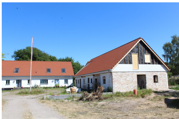
De gamle mursten bliver brugt til at bygge et nyt byggeri på samme sted i Veddinge
