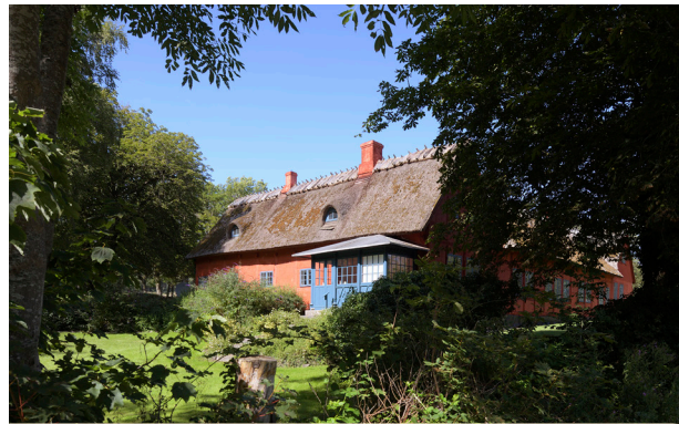
Den røde gård i Vindekilde, som er fredet, er opført med de materialer som var tilgængelige som strå, kalk, ler, træ
