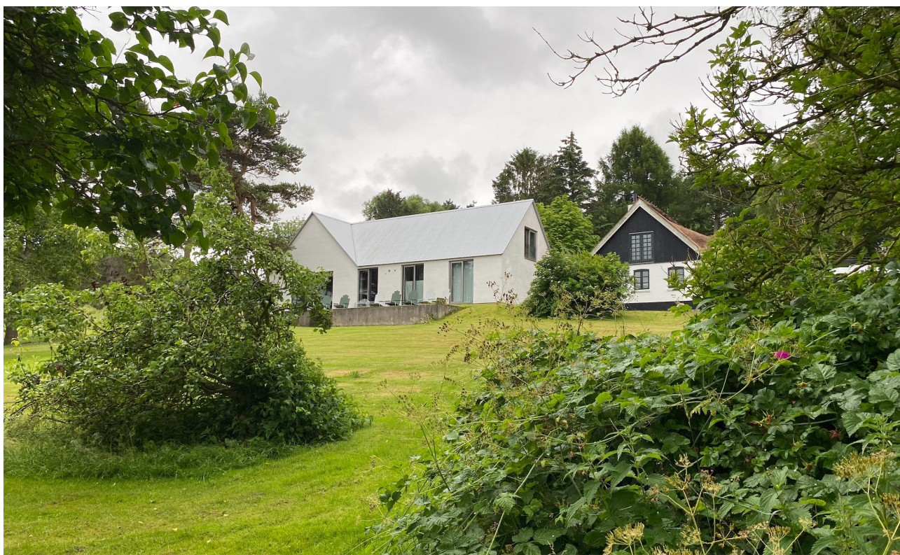
Det nyere hus til venstre er i proportioner og nænsomt tilpasset det ældre stråtægte hus til højre. Huset står i Høve og er tegnet af Leif Jørgensen
