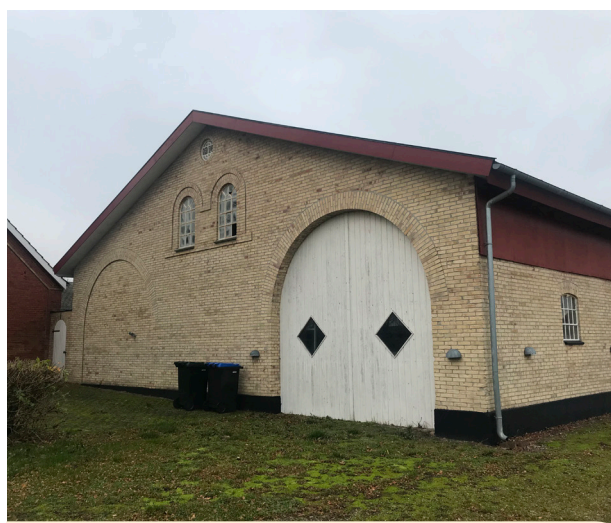
På Stålhøjvej i Asnæs har bygherren besluttet at beholde den gamle gård fra 1900-1923 og lave den om til 17 moderne lejligheder. Det betyder, at vi både sparer på jordens ressourcer, men også at områdets kulturhistorie bliver bevaret.
